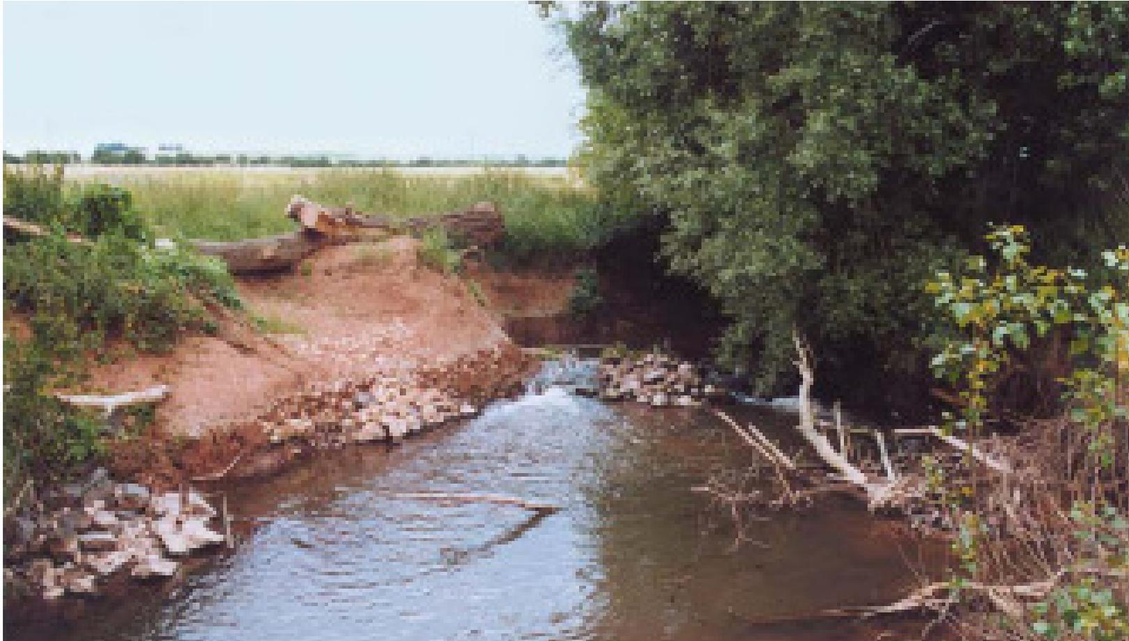
Punktuelle Entnahme und unregelmäßiger Wiedereinbau des Uferverbau
