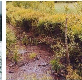
Bild 24 (links) Weidensteckhölzer quer zur Fließrichtung (Ergersborner Graben)
