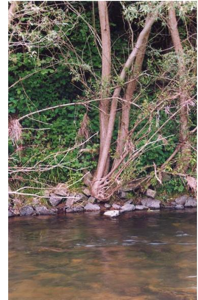
Bild 15 Aufbruch der Ufersicherung durch ausgeschlagene Weidensetzpflocke (Ahr)
