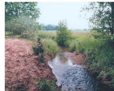
Bild 21 Uferabflachung und seitliche Aufweitung des Querprofils (Bleibach)
