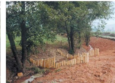
Bild 40 (links) Einbau von Pfahlreihen (Bauzustand) im Wäldersbach
