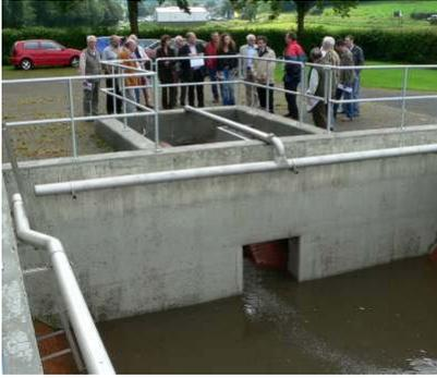
*Aus dem Regenüberlaufbecken (im Bild) wird das Mischwasser aus Hallschlag auf die schilfbewachsene Filterfläche geleitet und gelangt über die Tauberkyll in den Kronenburger See. BILD: ROMANOWSKI*
