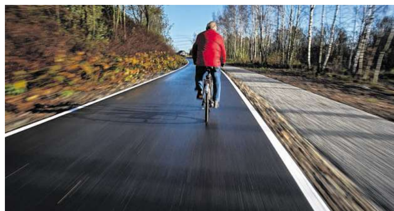
Sechs Meter für Radfahrer, ein getrennter Fußweg: So wie das erste Teilstück des RS 1 im Ruhrgebiet soll ein Radschnellweg sein. Foto: dpa
