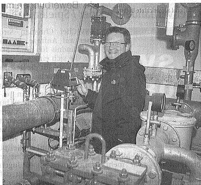
Ingenieur Stefan Bölte zeigt, wo das ankommende Roh-Biogas auf seine Inhaltsstoffe hin kontrolliert wird. Foto: ds
