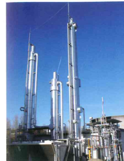
Biogasspeicher (links), Biogasaufbereitungsanlage (rechts) GFC.
