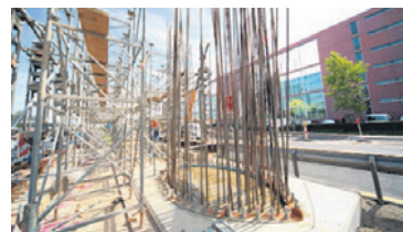
► Auch das Fundament für den Pylon ist bereits gegossen: Im Gegensatz zum ersten Entwurf steht dieser jetzt zwischen den Fahrspuren.
