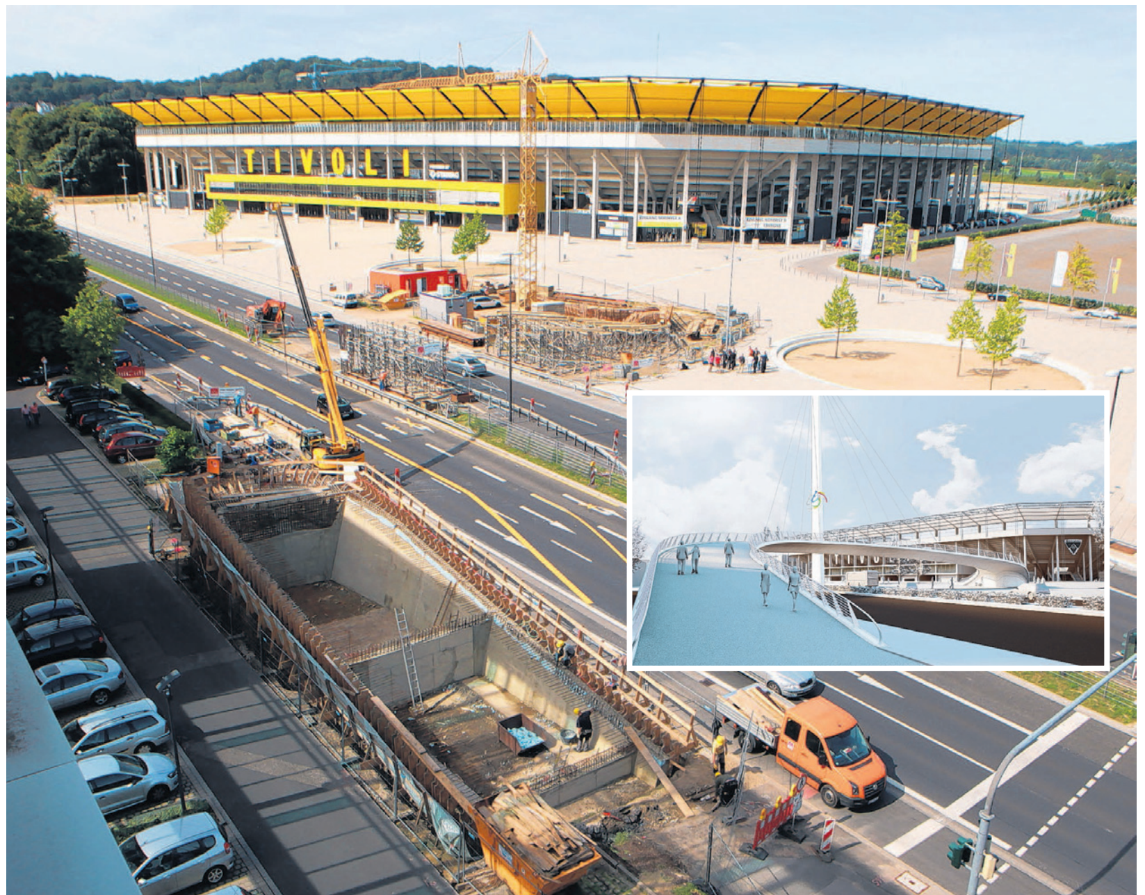
Die beiden Rampen für die Lager der CHIO-Brücke sind bereits gegossen (großes Bild, direkt neben der Fahrbahn). Sie bilden die Basis für die Fußgängerbrücke (siehe Graphik), die im kommenden März fertig gestellt sein soll. Foto: Andreas Steindl/Graphik Berg&Partner
