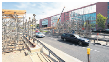
► Sperrung nachts vom 15. auf den 16. und vom 16. auf den 17. August: Schalarbeiten über die Krefelder Straße machen dies nötig.
