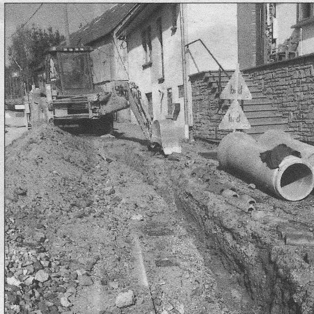
In Oudler sind die Kanalarbeiten in vollem Gange.
