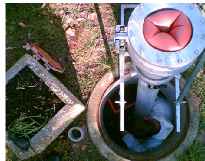
Schlauchlinereinbau
