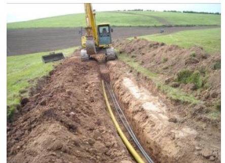
Biogasleitung und Leerrohre
