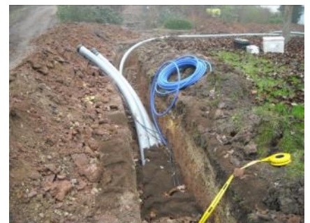
Nahwärmeleitungen und Steuerkabel
