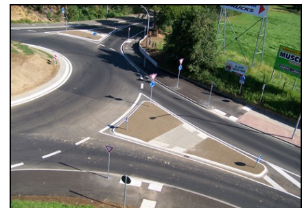
Fahrbahnteiler mit taktiller Leiteinrichtung
