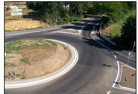
Fertigstellung Kreisverkehr (Blickrichtung Norden)
