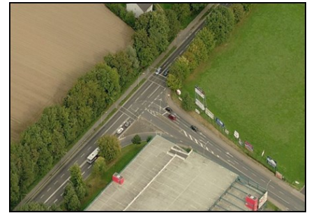
T-Einmündung vor Umbau (Vogelperspektive)
