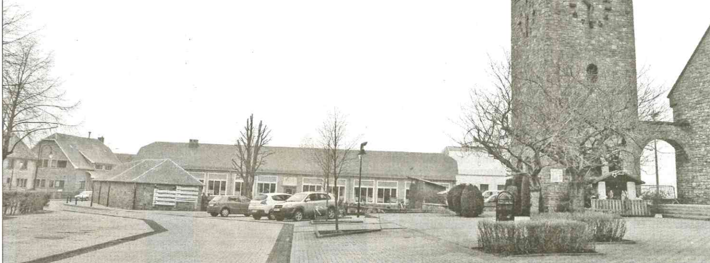
Sieben öffentliche Gebäude in einem Umkreis von 230 m im Zentrum von Rocherath-Krinkelt werden an das Nahwärmenetz angeschlossen.
