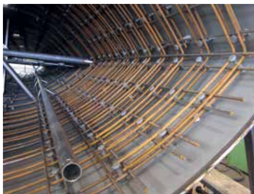
9 Innere Pylonbewehrung mit Kopfbolzen © Elmar Holzbach
