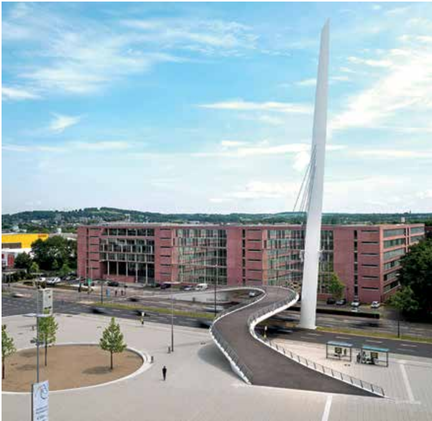
10 CHIO-Brücke als neues »Eingangstor« für Aachen © Jörg Hempel
