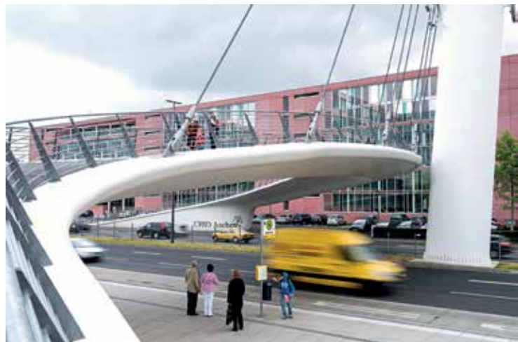
4 Pylon mit Seilabspannung © Jörg Hempel
