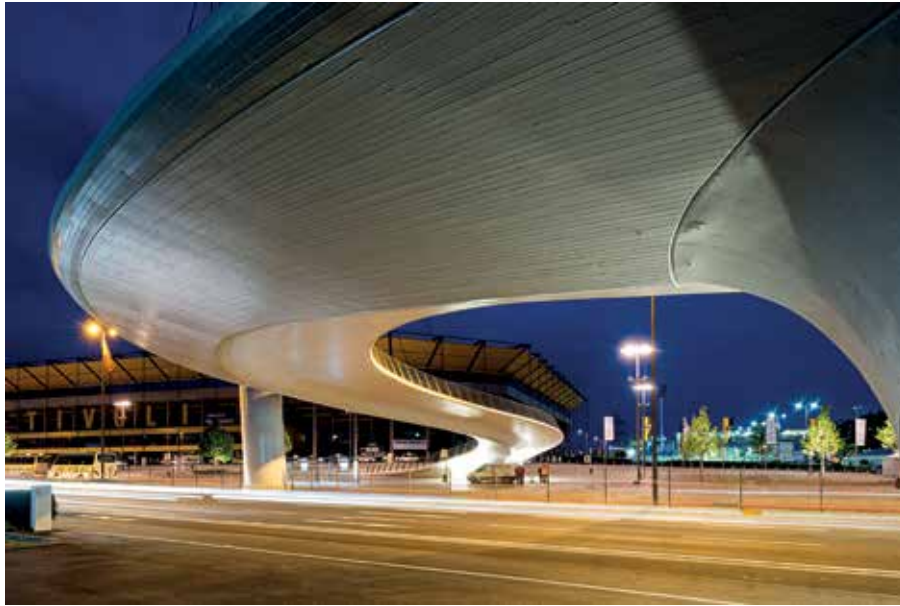
3 Unterseite des Brückenbauwerks © Jörg Hempel
