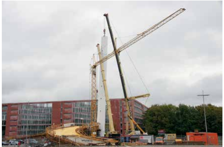
6 Montage des Pylonunterteils © Astrid Webers
