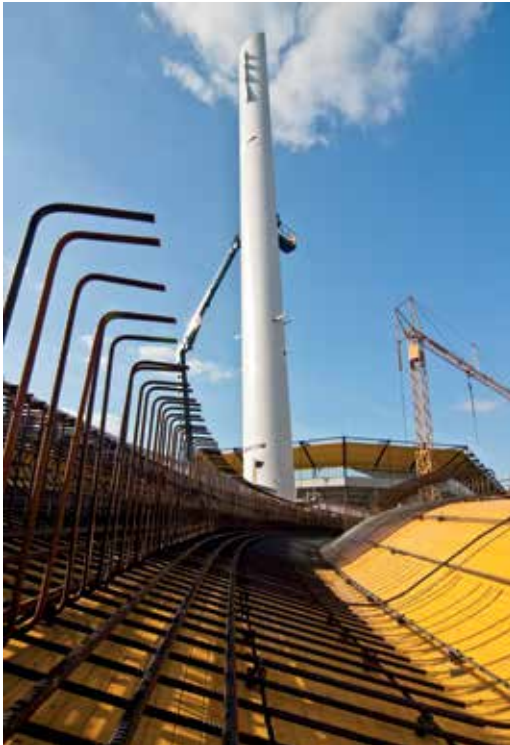
8 Schalung und Bewehrung des Überbaus © Peter Stollenwerk
